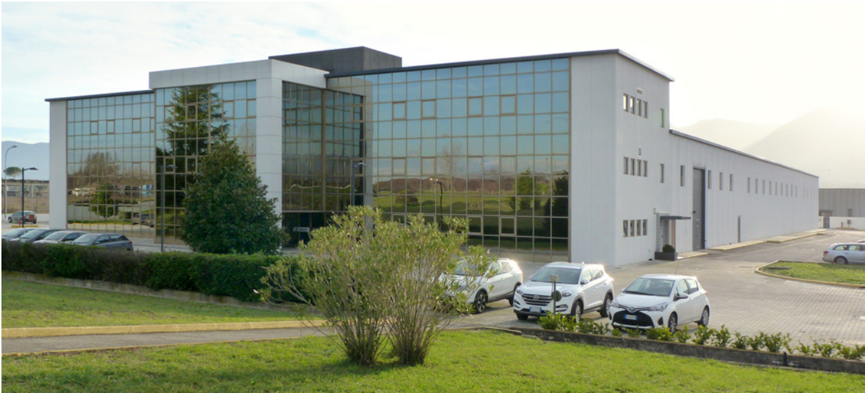
Sede del Datacenter di Frosinone
